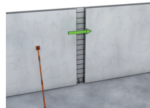
4 Ripage des armatures de liaison dans le prémur 2.
