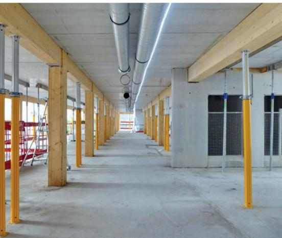
Sur chantier, la Dalle BB devient Plancher BB lorsque vous coulez 5 cm de dalle de compression\*, pour des planchers BB de 20 à 35 cm.
