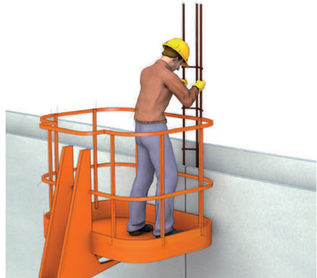
Figures 27 et 28. Mise en place des aciers de liaison
