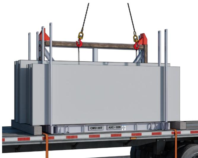
2°) Accrocher le prémur à l'appareil de levage.
